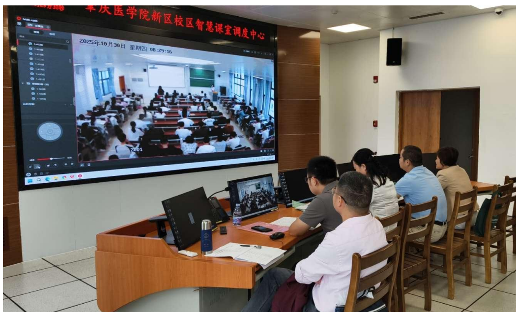
图 1 图书馆 10 楼监控室
